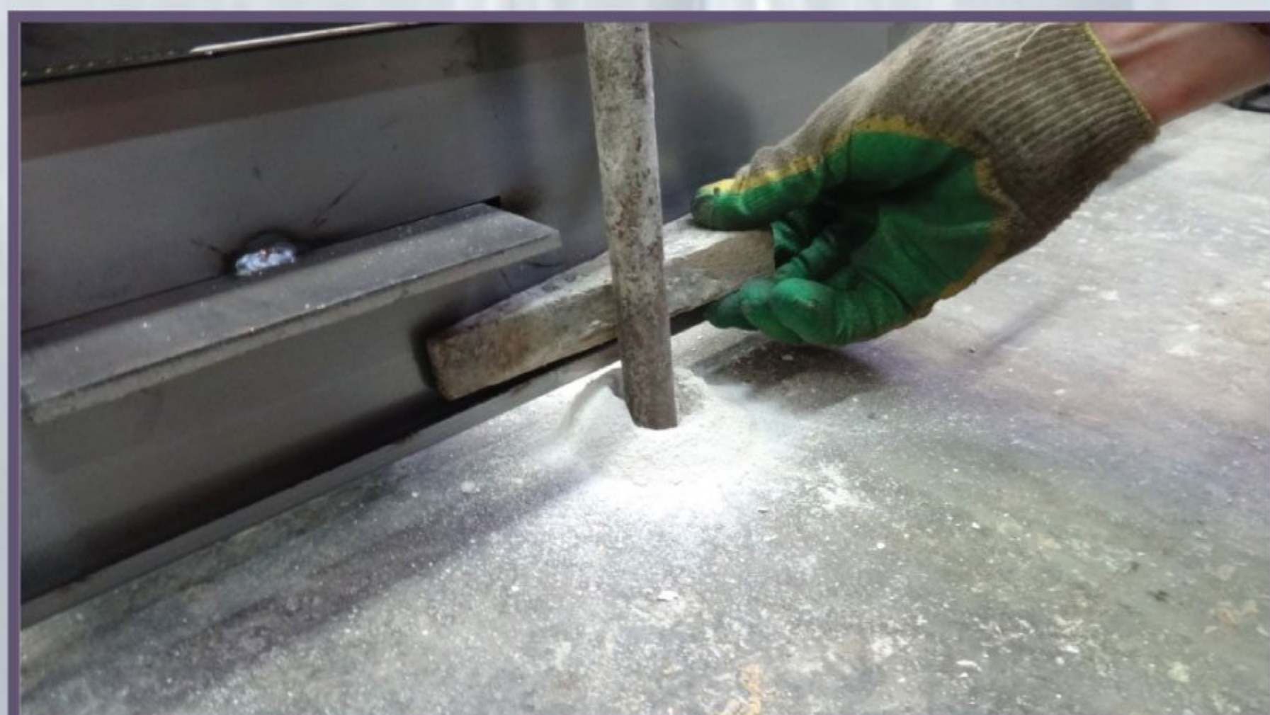
7 Установка треугольных деревянных клиньев между опалубкой и штырями для дополнительного крепления
