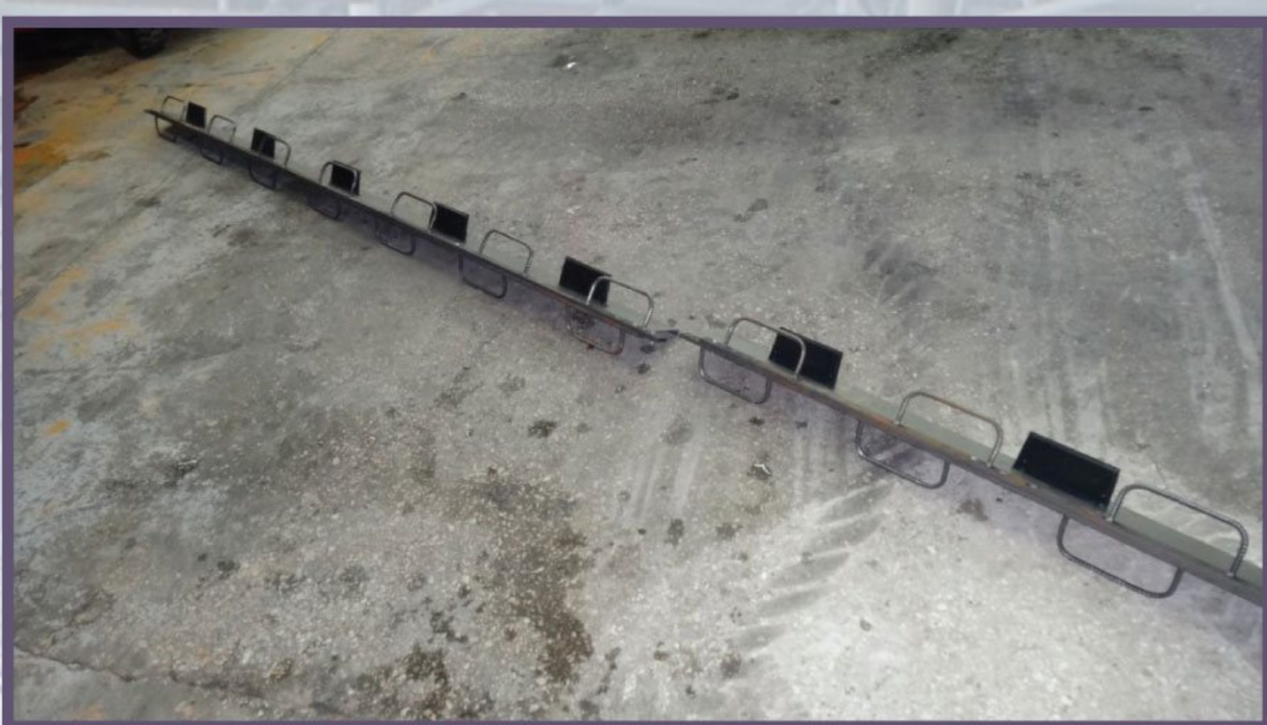
2 Раскладываем опалубку по периметру бетонируемой карты в одну линию «стык в стык» как показано на фотографии
