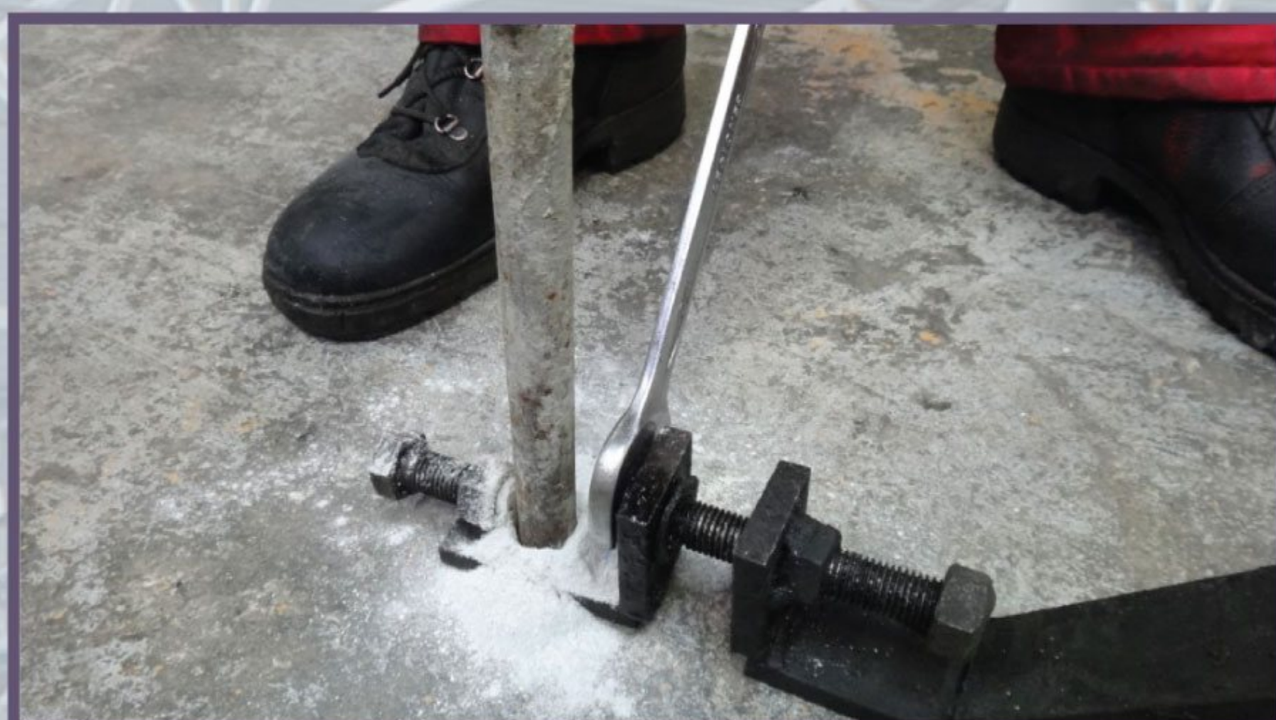
5 Выравнивание опалубки выполняется путем натягивания шнуровки и подгонки в одну линию при помощи регулировочных болтов, находящихся на фиксаторах
