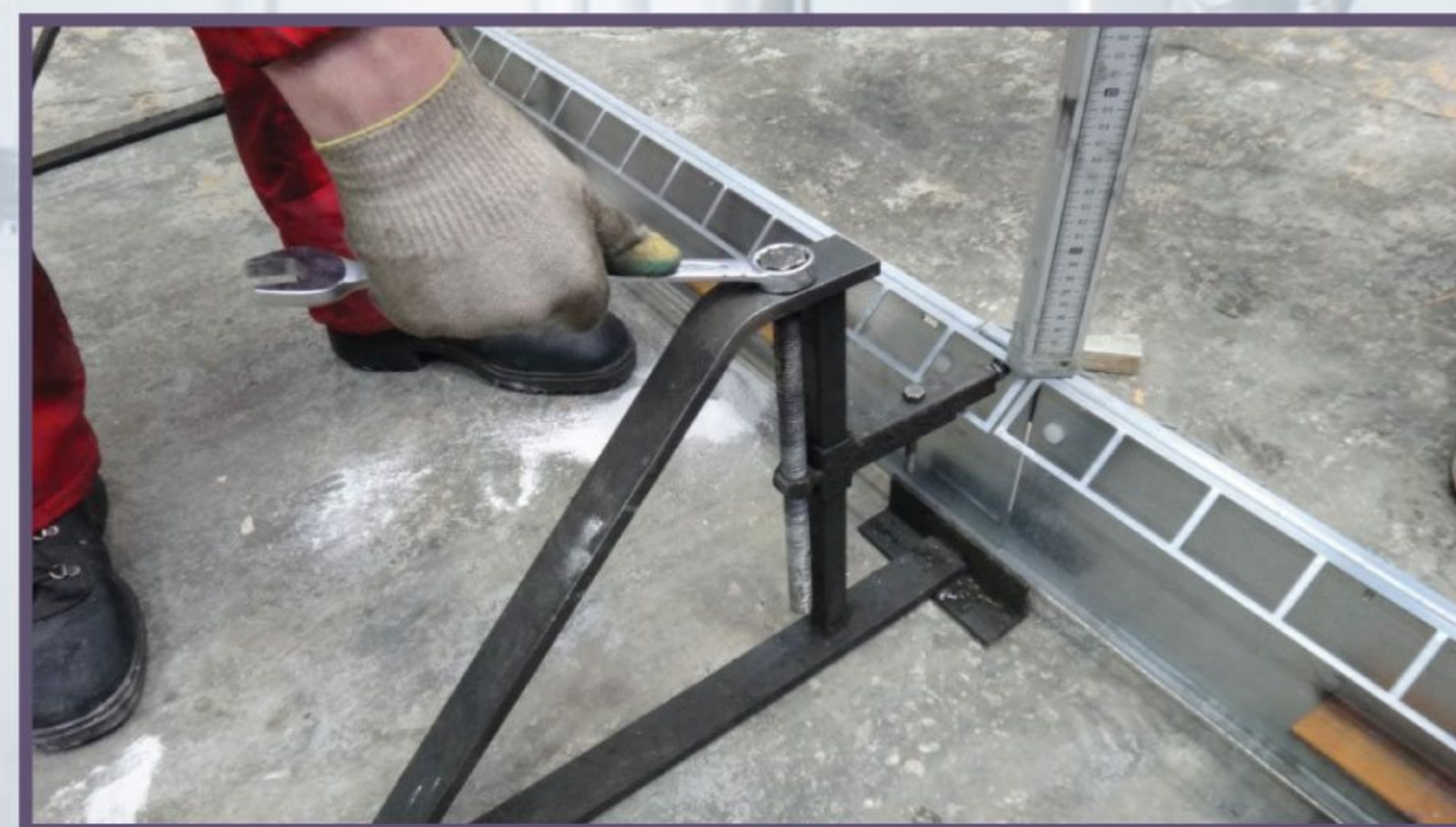
7 С помощью нивелира устанавливаем опалубку в проектное положение, регулируя ключом вертикальное положение
