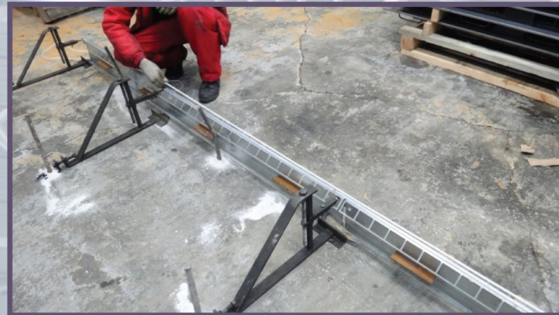
5 Выравнивание опалубки выполняется путем натягивания шнура и подгонки в одну линию.
