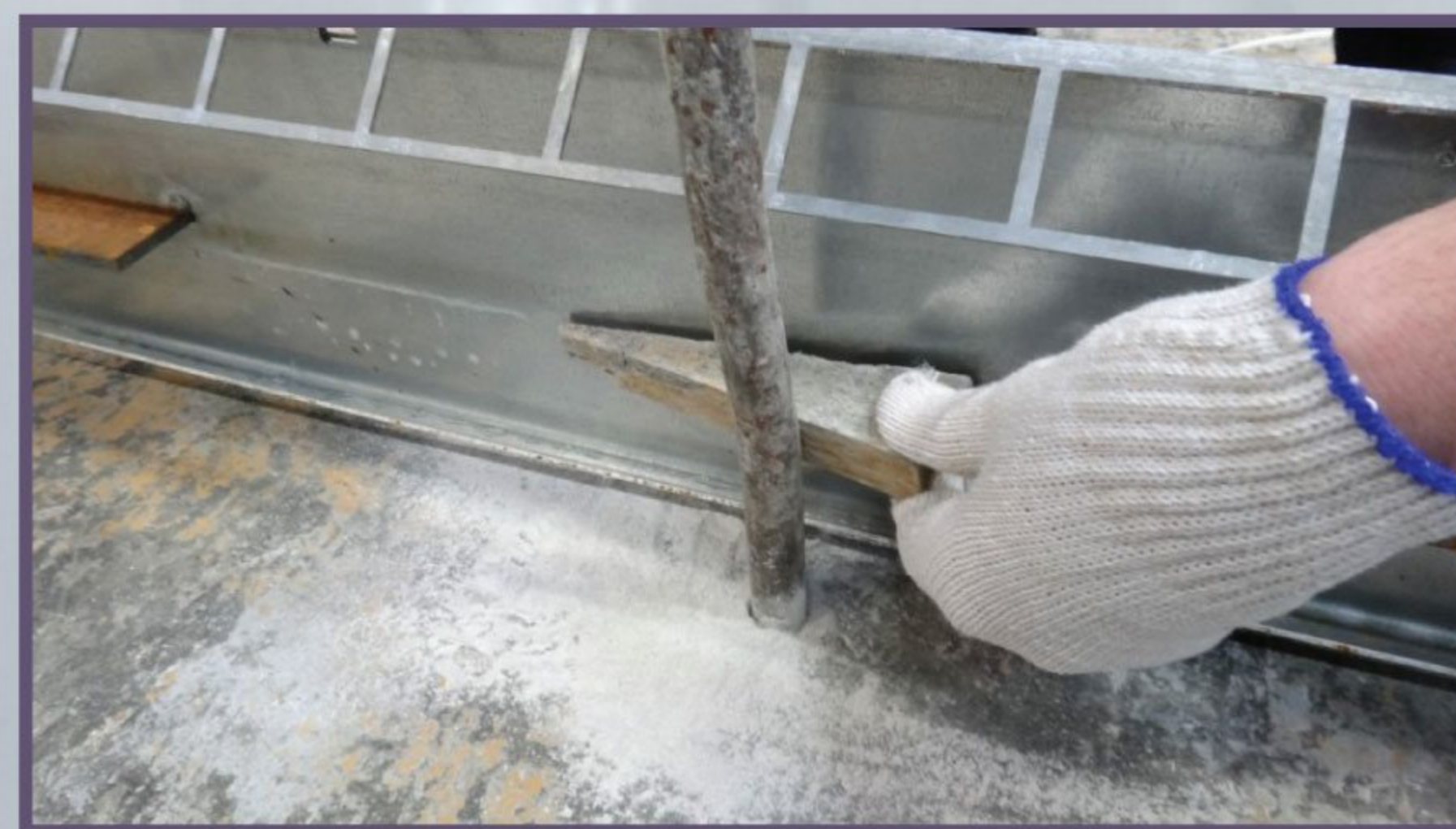
8 Установка треугольных деревянных клиньев между опалубкой и штырями для дополнительного крепления.
