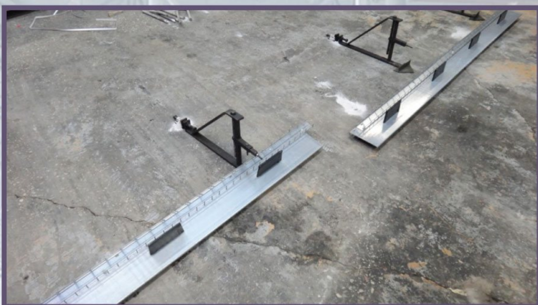
2 Раскладываем опалубку по периметру бетонированной карты в одну линию «стык в стык» как показано на фотографии
