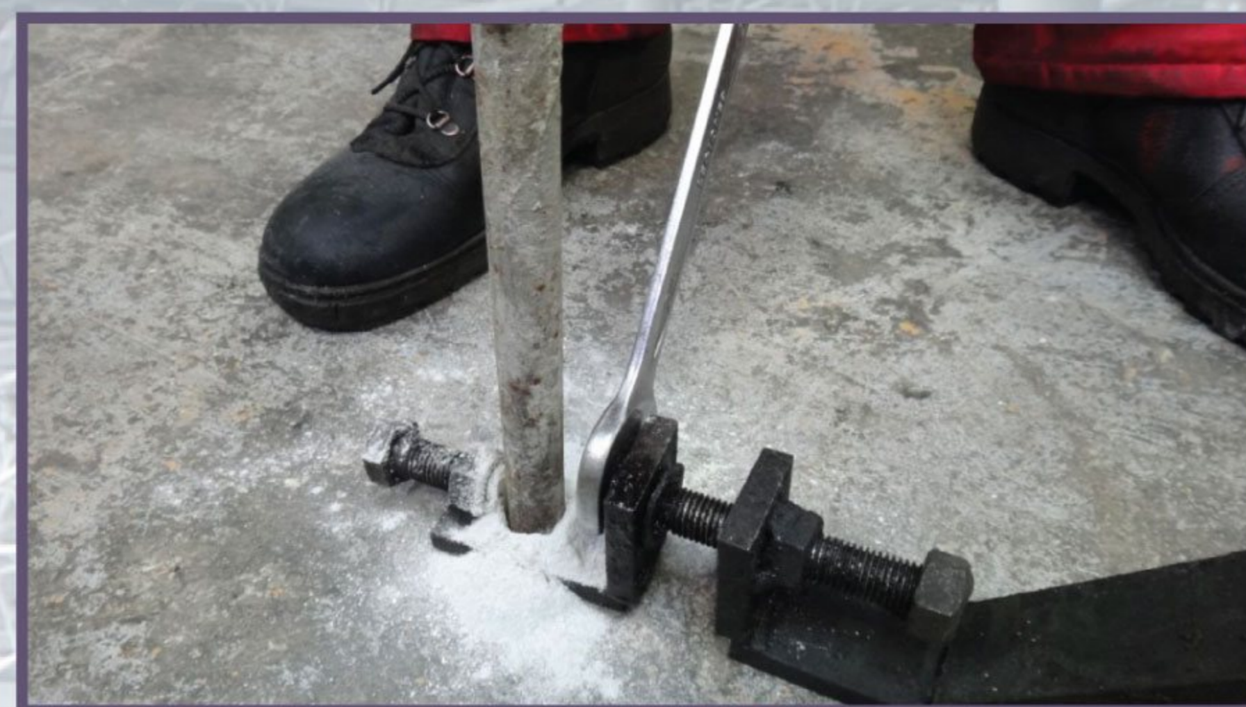
6 Регулируем опалубку ключом в горизонтальной плоскости
